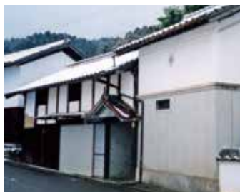
修築前の入口の状況
