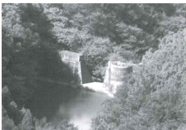
写真6 幸口ダム(長浜町)
