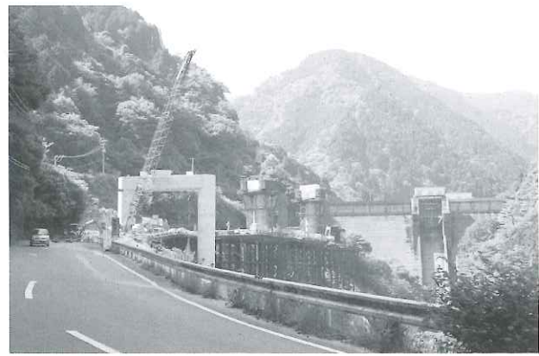
写真7：改良中の主要地方道「新居浜別子山線」（青龍橋）
