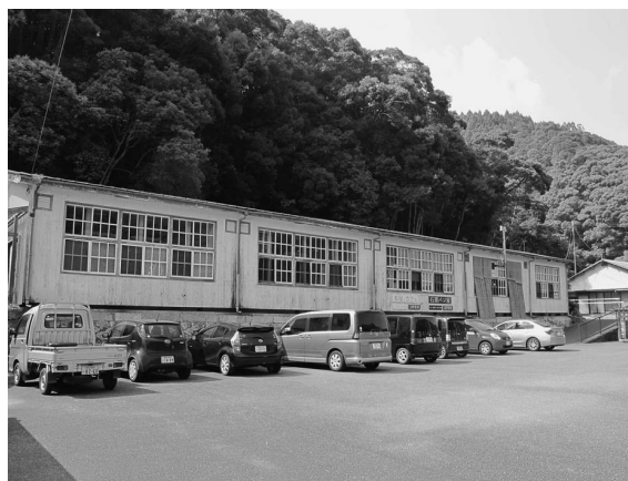
カフェに再生した木造校舎
