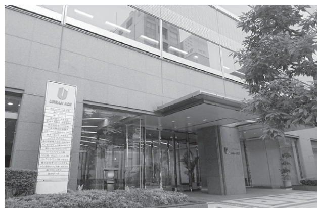
西条市大阪事務所の外観
