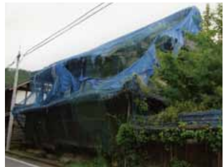
建物全景(平成21年夏)
