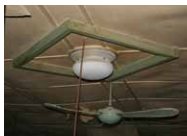
レトロな天井の様子
