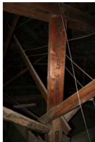
トラスに貼りつけてあった棟札
