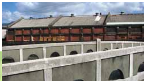
旧東洋紡績 煉瓦倉庫、美名瀬橋
