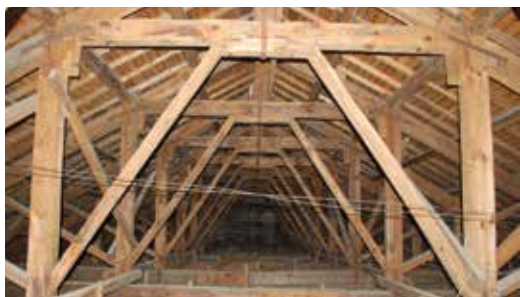
屋根裏のトラス
