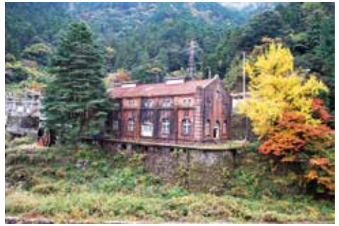
旧端出場水力発電所
