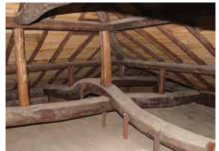
屋根裏の和小屋、曲材の梁
