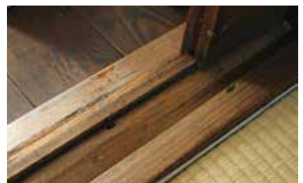
固い桜材のレール、100年の使用に耐えている
