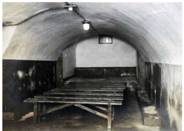
竣工時の内部（浜上建設・蔵）
