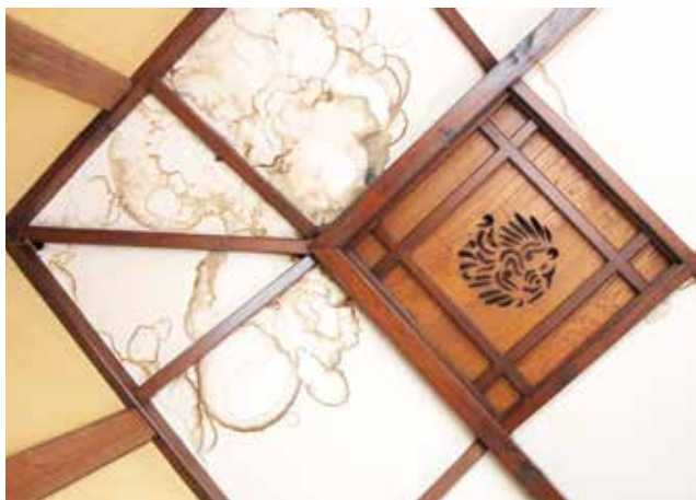
二階議場の天井換気に見られる意匠
