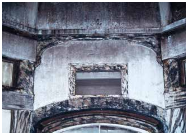
マーブル技法が残っていた頃の様子(浴室内入り口付近)
