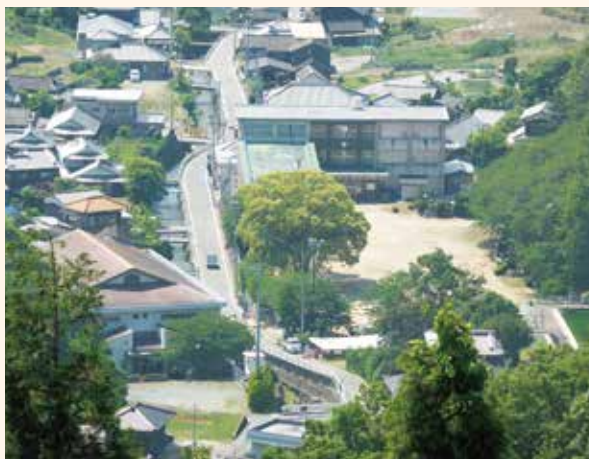
旧櫛生小学校の全景
