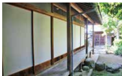
座敷濡れ縁から御成門方向を見る
