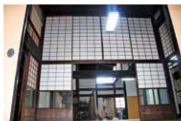
採光の工夫・二段構えの障子
