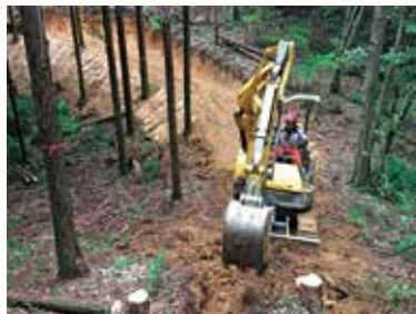
作業道開設の様子
