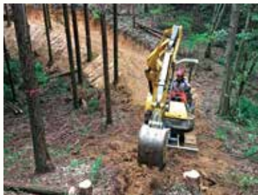
作業道開設の様子
