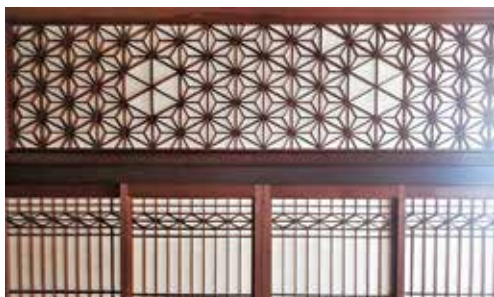
二階座敷の書院欄間組み格子
