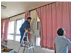
窓用クーラー設置状況
