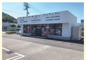
砥部支店駐車場にコインランドリーがオープン (2022年7月)
