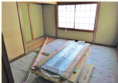
改修途中の「ゲストハウスみちしお」
