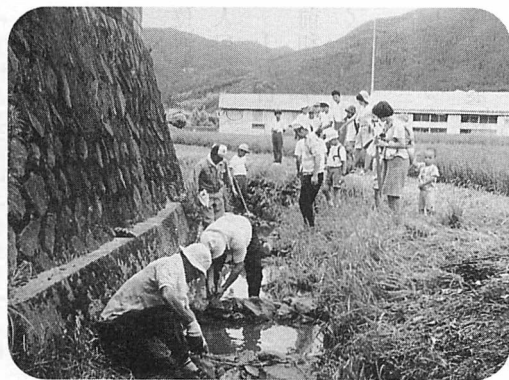
炭の敷設作業の様子
