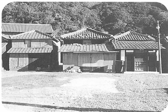
改造された船蔵・周辺も整理され効果がでている
