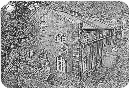
旧水力発電所
