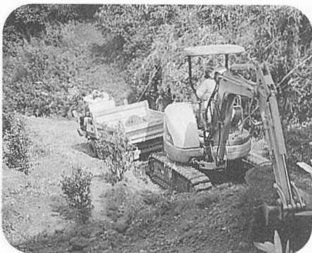
重機を使った園内作業道の設置作業
