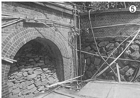
保内町・大峰銅山坑口
