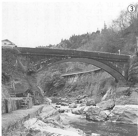
写真のように、コンクリート壁体が久万川をまたいでいる。この種は、県下に六橋確認された。三和橋（川内町・T11）、とまかわ 柳川橋（面河村・T14）、河口橋（西条市・T14）、志川橋（丹原町・S6）、そして別子鉱山鉄道の桧尾川橋梁（新居浜市・S6）である。
