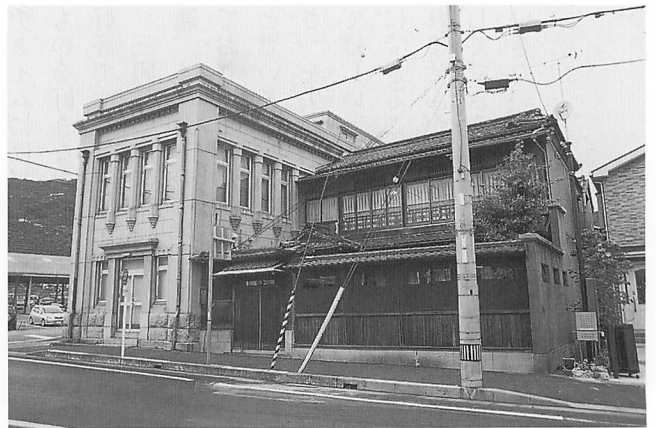
居宅との接合部
