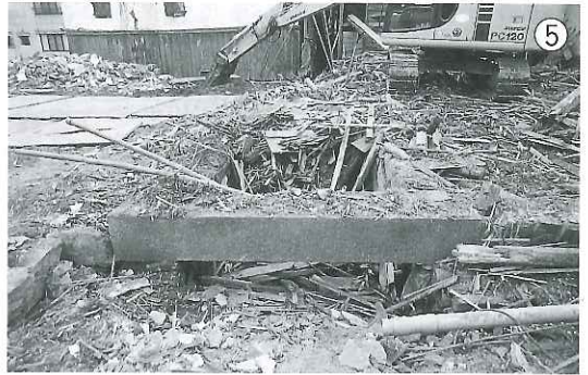
解体後に残る かんぎ 雁木遺構
