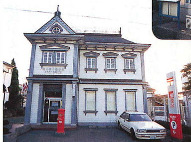
◀ 鴨川郵便局 (松山市) これのみ現役で、平成になり新築
