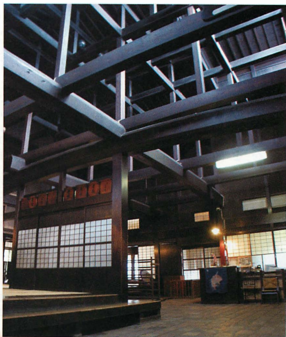
伝統的な木組みの様子
