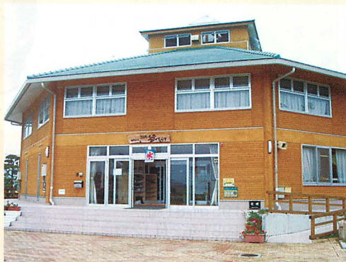
totoの収益によるスポーツ振興くじの助成を受け建設された文化とスポーツの拠点施設「きよね夢てらす」
