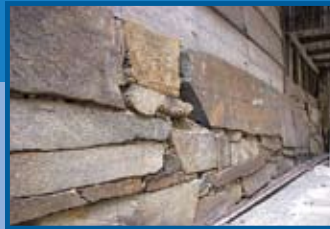
長屋門の基礎石垣
