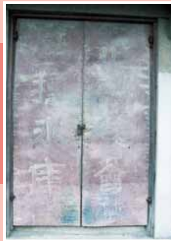
取り壊された土蔵の扉
