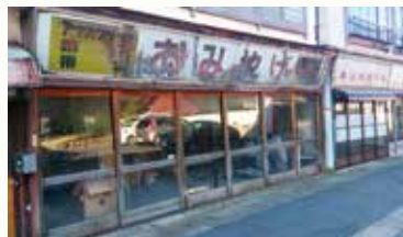
改修前のことり舎
