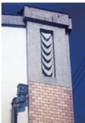
コーナー外壁意匠 (洗い出し、磁器タイル、銅製桶)
