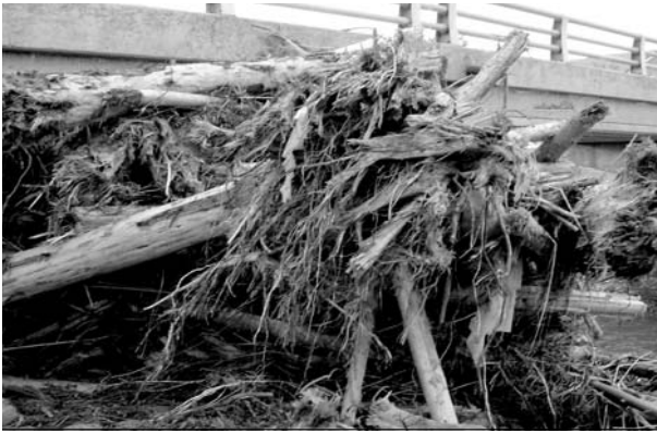
写真-2 流木により河道が閉塞された状況(西条市渦井川)
