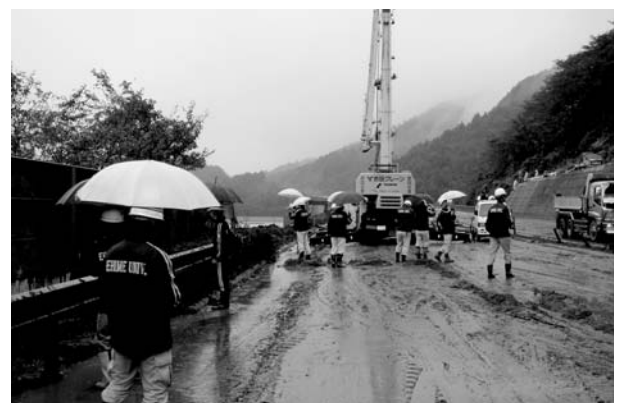
写真-1 新居浜市大生院での愛媛大学調査団による斜面崩壊調査の状況（松山自動車道本線にて）
