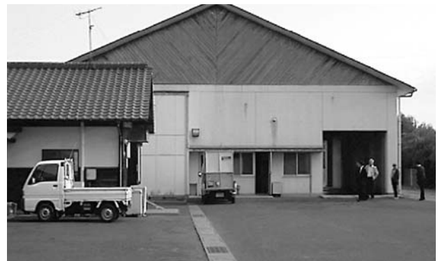
築上町液肥製造施設
