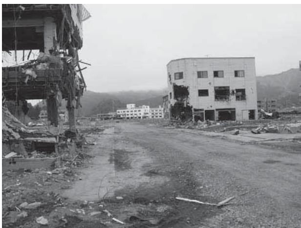
写真—2 大槌町の被災状況（7月7日）
