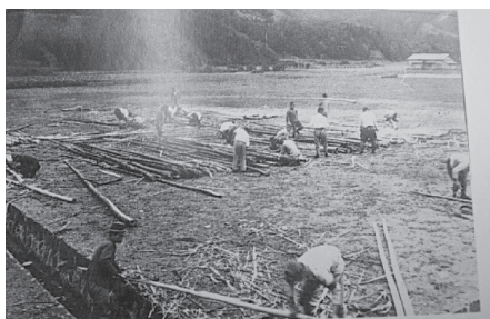
知今堂建築 足場づくり（昭和18年）
