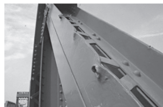
長浜大橋（大洲市）
