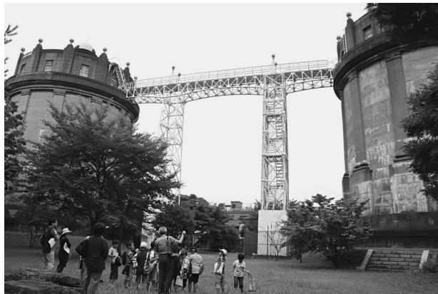
小学生・構内の1号塔と2号塔繋ぐトラス橋見学
