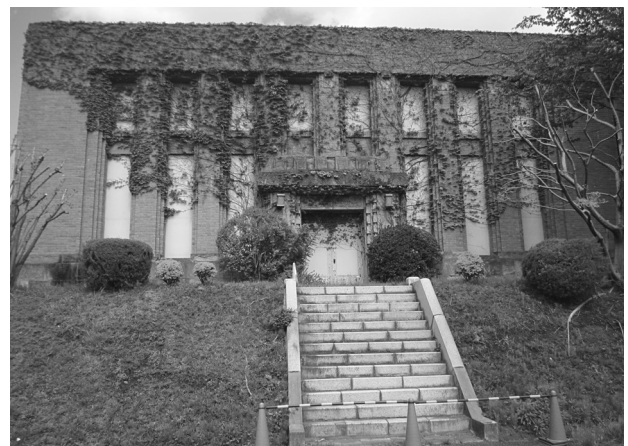
選奨土木遺産の第一ポンプ所
