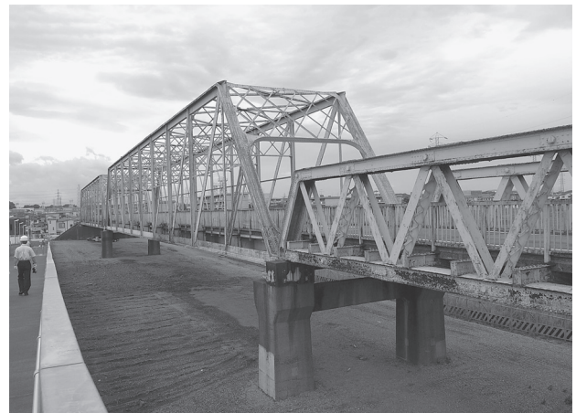
解体直前の江ヶ崎跨線橋
