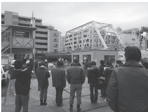
組み立てたトラスを横に移動させる架設方法の見学会
