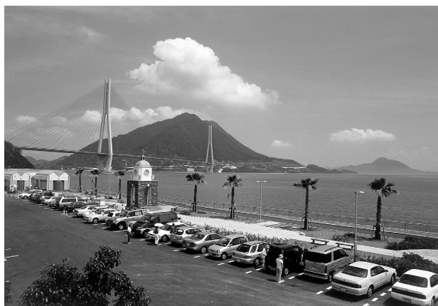
写真1 道の駅多々羅しまなみ公園
