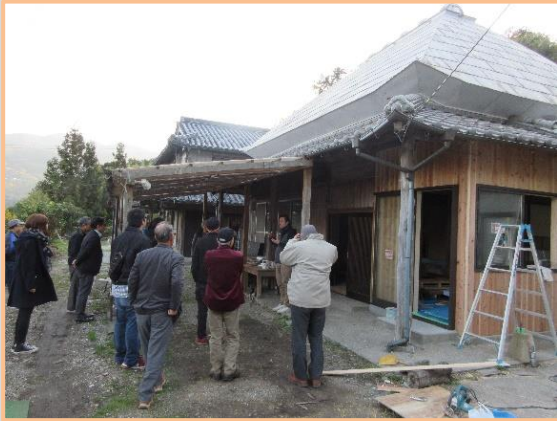
改修中の空き家
