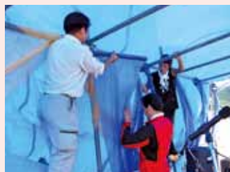
ステージ組み立て作業
