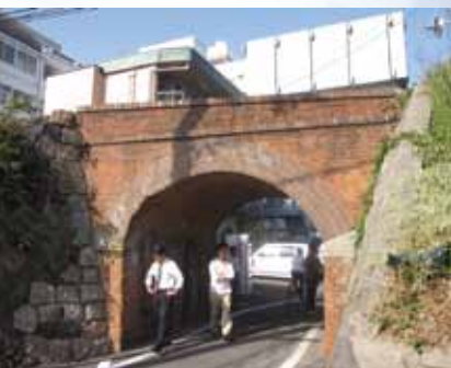
煉瓦アーチ橋 (伊予鉄道 鉄道橋)
