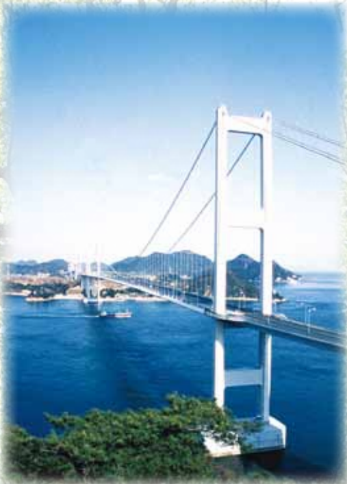
最後に完成した来島海峡大橋
