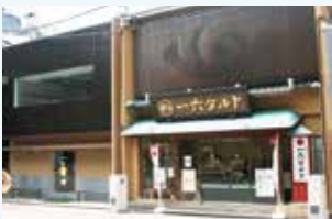
ファサード整備後
