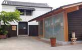
修繕された蔵(奥)と伝統工法の新築建物(前)
