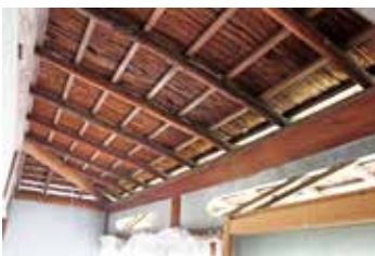
茶室内部、小舞天井と採光欄間
