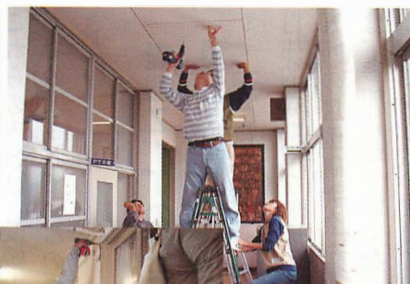
天井裏配線工事
