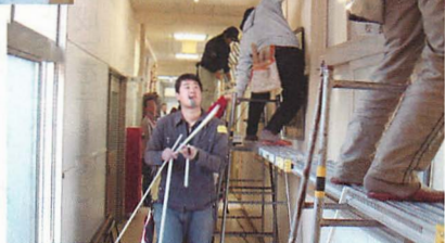
廊下の配線工事
