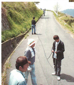
ケーブル敷設作業
