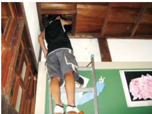
〈写真4〉翠小での学校探検(天井裏の確認)
