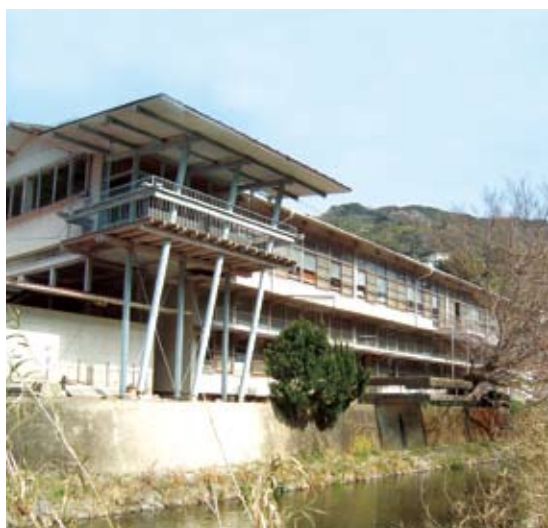
〈写真1〉日土小学校の東校舎（撮影KIKUCHI）
