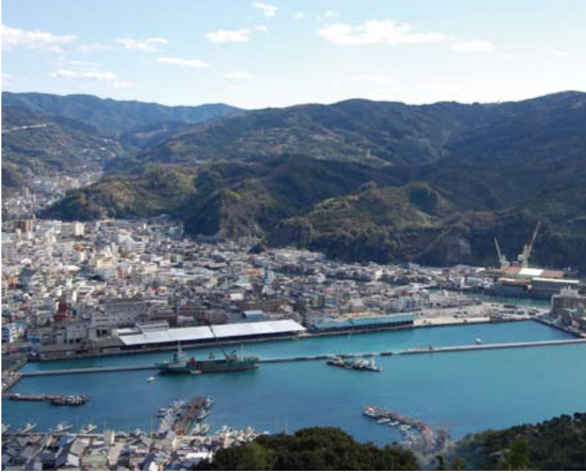
整備中の八幡浜港
